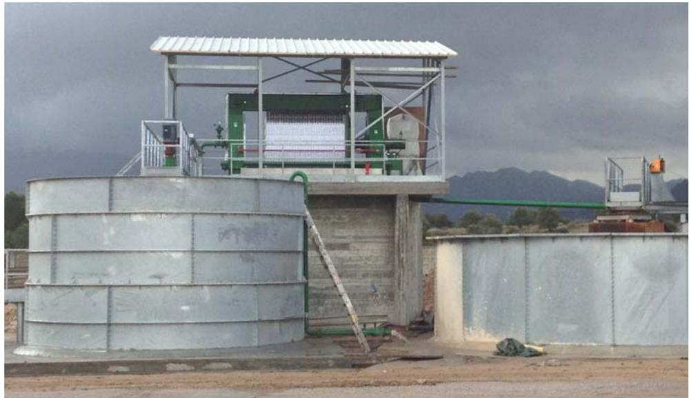
mere che accolgono il fango caricato da una pompa; dopo la fase di riempimento, il fango viene tenuto in compressione e tale spinta fa trafilare l'acqua attraverso le tele. L'acqua così separata viene inviata ad una vasca di raccolta passando in un sistema di canali.
